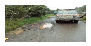
Vista del tramo ejecutado entre el corregimiento de San Juan y Santa Ana y las fallas del material instalado que reflejan la inestabilidad del terreno.
