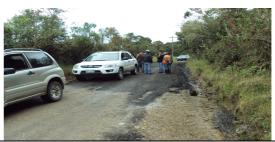
La inestabilidad y los fallos son, recuperados mediante la excavación del material deteriorado y la instalación de rajón (piedra) y recebo seleccionado. El acabado final del fresado extendido, se encuentra afectado por la presencia de agua que circula de manera permanente, paralelo al tramo ejecutado.
